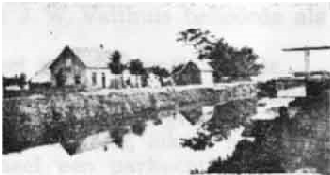
Afbeelding 1. Het Overijssels Kanaal in vroegere tijden (Bron: www.kanalenenwegen.nl )
