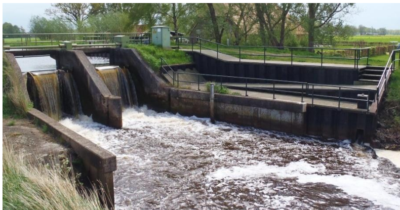
Figuur 29 Stuw Kanaaldijk-Noord, met rechts de vispassage
