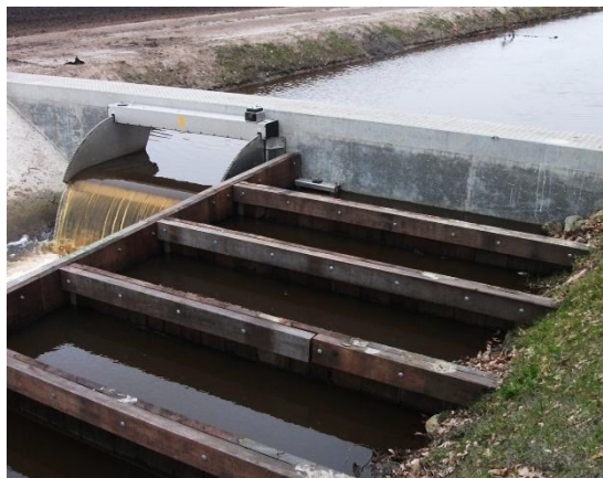
Figuur 23 Stuw Klunder met vispassage
