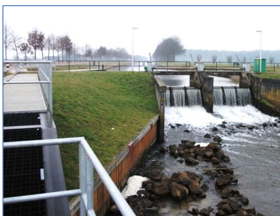
Figuur 42 Stuw Wijhe, met links de vispassage
