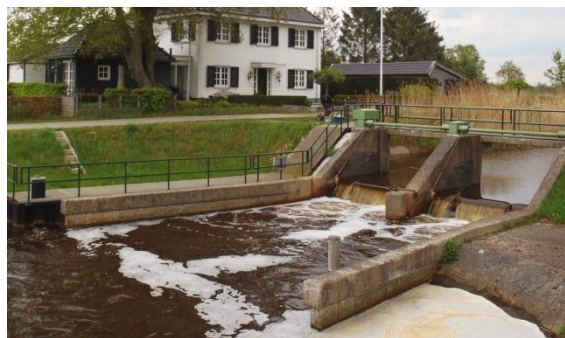
Figuur 33 Stuw Brok, met links de vispassage
