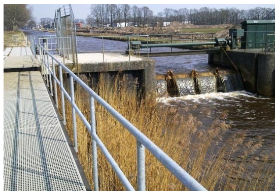
Figuur 7 Stuw De Meele, met links de vispassage
