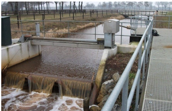
Figuur 19 Stuw Snijder Weemerveldweg, met rechts de vispassage
