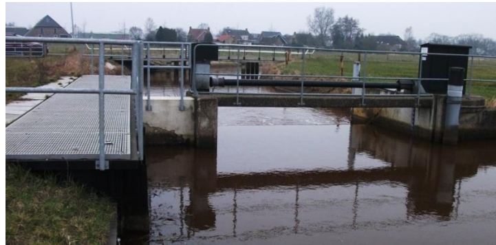
Figuur 11 Stuw Hengsteboer, met links de vispassage
