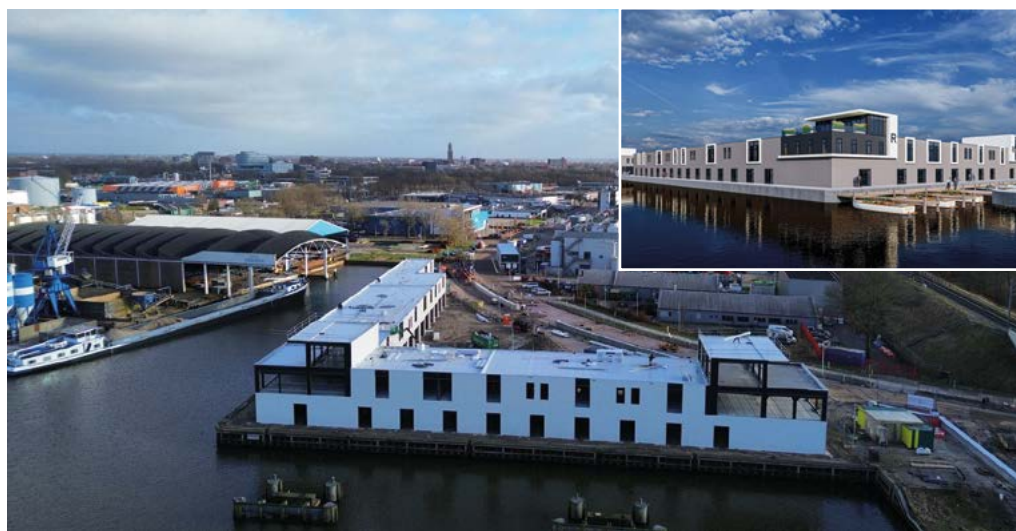
NIEUW PAND - ZICHT OP HET WATER
