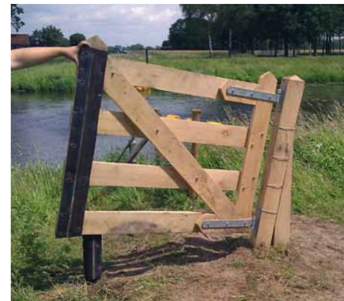
Klaphek: één van de verbeteringen aan de visstekken bij de stuw van Vechterweerd.
